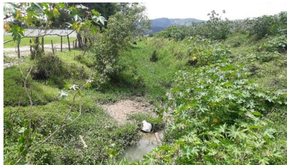
FIGURA 11 – VALA DE DRENAGEM LOCALIZADA NA À RUA JOSÉ TEODORO CORRÊA FONTE: PLANO DE MACRODRENAGEM DE POTIM, 2019
