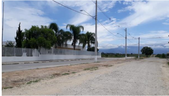
FIGURA 10 – VALA DE DRENAGEM LOCALIZADA NA À RUA JOSÉ TEODORO CORRÊA FONTE: PLANO DE MACRODRENAGEM DE POTIM, 2019
