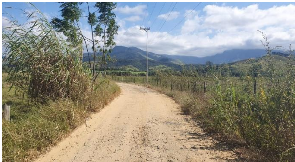
FIGURA 16 – TRAVESSIA LOCALIZADA NA ESTRADA DA ÁGUA BRANCA FONTE: PLANO DE MACRODRENAGEM DE POTIM, 2019
