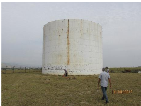
FIGURA 49 – RESERVATÓRIO APOIADO – VISTA 1 FONTE: ACERVO DO AUTOR, 2019
