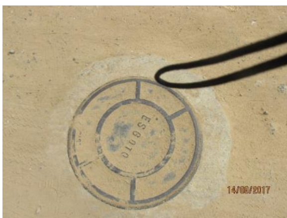
FIGURA 61 - POÇO DE VISITA – VISTA 1 FONTE: ACERVO DO AUTOR, 2017
