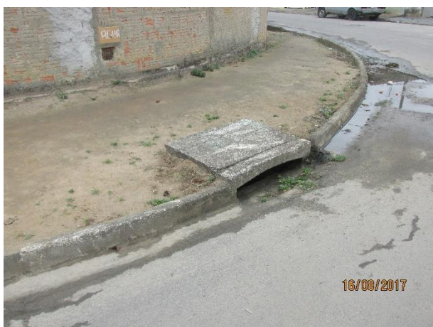
QUADRO 60 – CALÇAMENTO CDHU – VISTA 01 FONTE: ACERVO DO AUTOR, 2019
