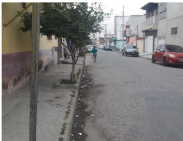
QUADRO 62 – CALÇAMENTO CENTRO FONTE: ACERVO DO AUTOR, 2019
