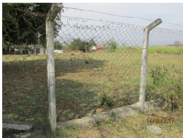
FIGURA 55 – RESERVATÓRIO VISTA ALEGRE – VISTA 2.
