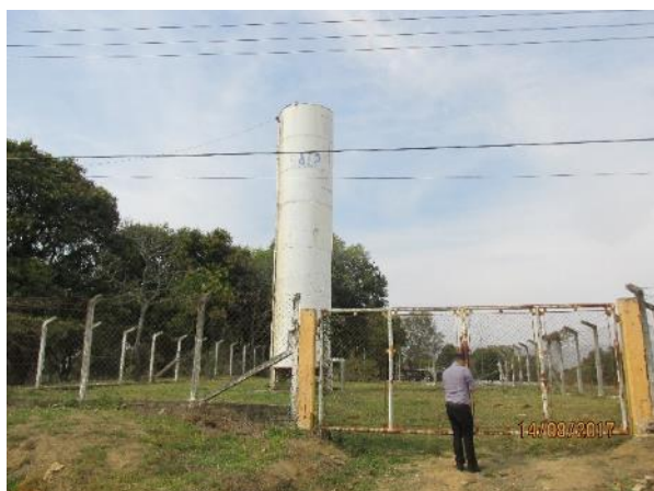
FIGURA 54 – RESERVATÓRIO VISTA ALEGRE – VISTA 1.
