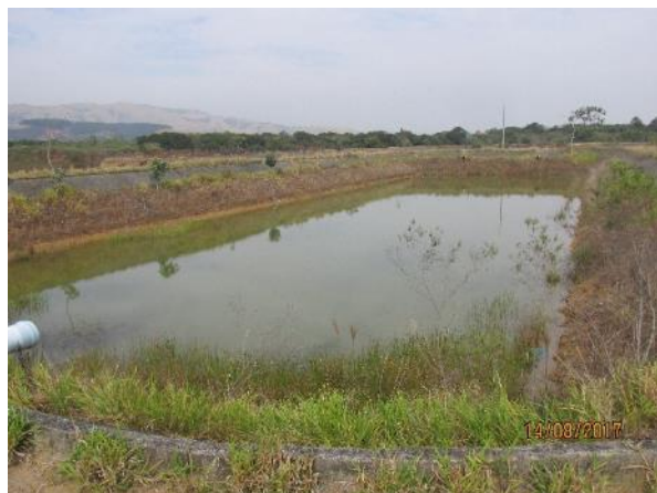
FIGURA 64 – ETE PRINCIPAL – VISTA 2 FONTE: ACERVO DO AUTOR, 2017
