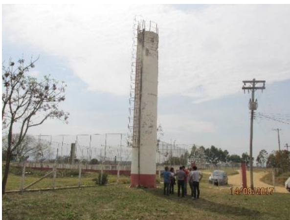
FIGURA 58 – RESERVATÓRIO MIGUEL VIEIRA – VISTA 1 FONTE: ACERVO DO AUTOR, 2017
