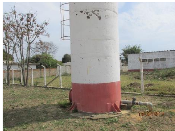
FIGURA 59 – RESERVATÓRIO MIGUEL VIEIRA – VISTA 2 FONTE: ACERVO DO AUTOR, 2017
