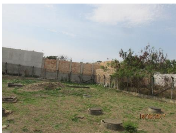
FIGURA 65 – ETE MIGUEL VIEIRA – VISTA 1 FONTE: ACERVO DO AUTOR, 2017
