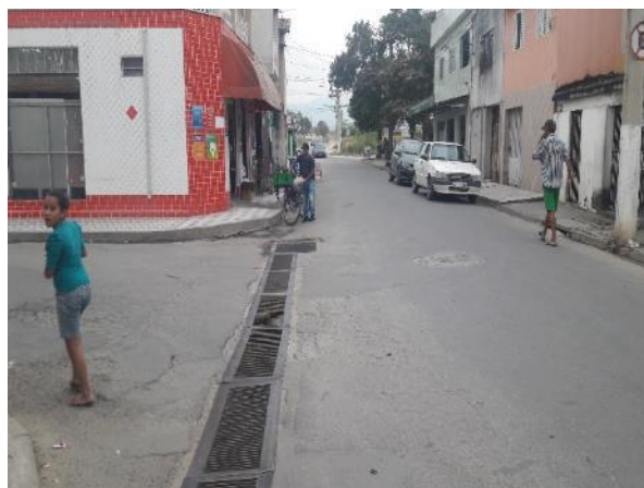
FIGURA 73 – CANALETA E ÁREA DE INUNDAÇÃO NO BAIRRO CENTRO FONTE: ACERVO PESSOAL, 2017
