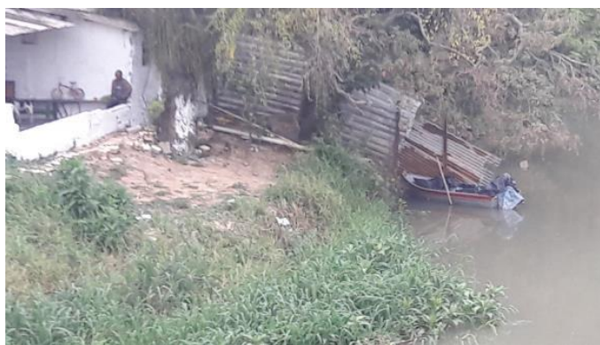
FIGURA 69 - CONSTRUÇÃO IRREGULAR DENTRO DE APP FONTE: ACERVO PESSOAL, 2017
