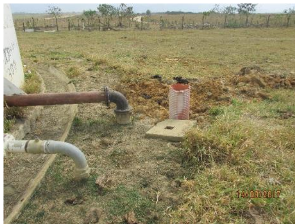
FIGURA 50 - RESERVATÓRIO APOIADO – VISTA 2 FONTE: ACERVO DO AUTOR, 2019
