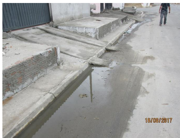
QUADRO 61 – CALÇAMENTO CDHU – VISTA 02 FONTE: ACERVO DO AUTOR, 2019
