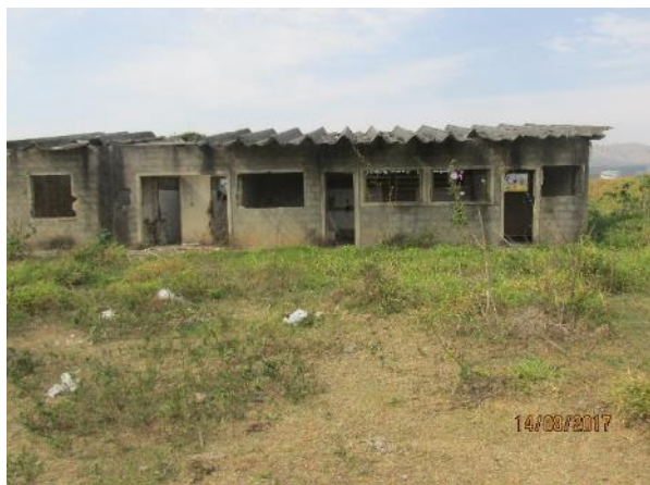
FIGURA 63 – ETE PRINCIPAL – VISTA 1 FONTE: ACERVO DO AUTOR, 2017
