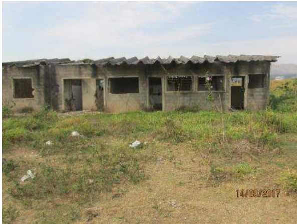
FIGURA 52 – ETE PRINCIPAL – VISTA 1 (FONTE: ACERVO DO AUTOR, 2017)
