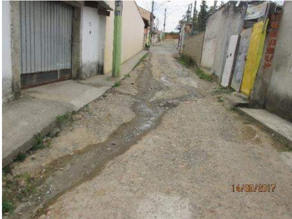
FIGURA 94 - DRENAGEM SUPERFICIAL NO BAIRRO MIGUEL VIEIRA (FONTE: ACERVO PESSOAL, 2017)
