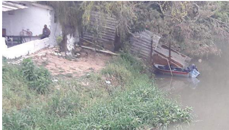
FIGURA 87 - CONSTRUÇÃO IRREGULAR DENTRO DE APP (FONTE: ACERVO PESSOAL, 2017)
