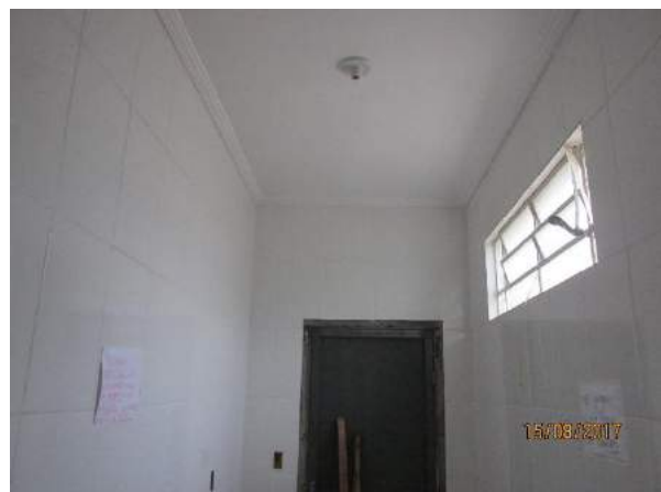
FIGURA 74 - ARMAZENAMENTO IRREGULAR DE RSS NO PSF-C (FONTE: ACERVO DO AUTOR, 2017)
