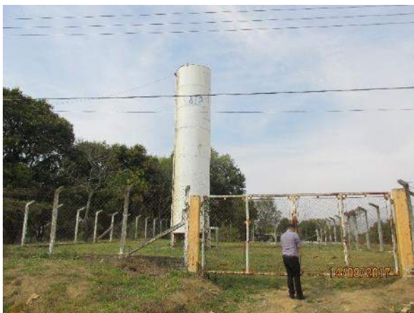
FIGURA 43 – RESERVATÓRIO VISTA ALEGRE – VISTA 1.
