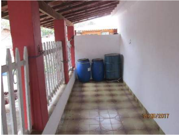
FIGURA 81 – ARMAZENAMENTO IRREGULAR DE RSS NO ESF-E (EXTENSÃO)
