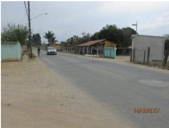
FIGURA 92 – DRENAGEM SUPERFICIAL NO BAIRRO VISTA ALEGRE (FONTE: ACERVO PESSOAL, 2017)
