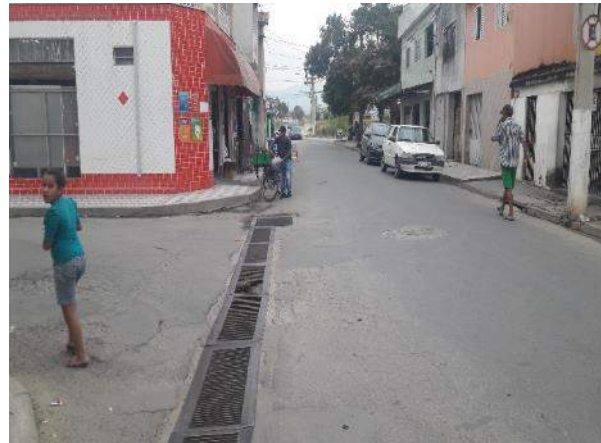
FIGURA 91 – CANALETA E ÁREA DE INUNDAÇÃO NO BAIRRO CENTRO (FONTE: ACERVO PESSOAL, 2017)
