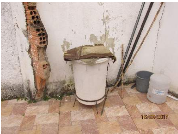
FIGURA 79 – ARMAZENAMENTO IRREGULAR DE RSS NO ESF-E (FONTE: ACERVO DO AUTOR, 2017)
