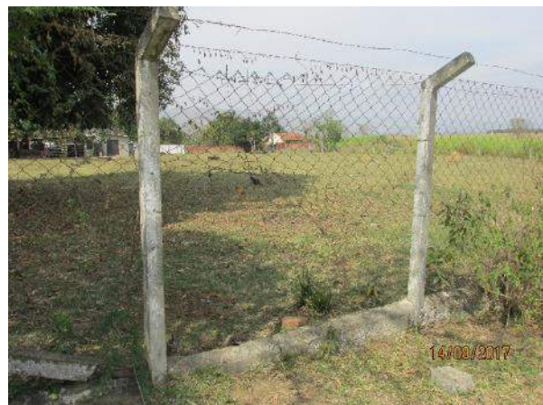
FIGURA 44 – RESERVATÓRIO VISTA ALEGRE – VISTA 2.
