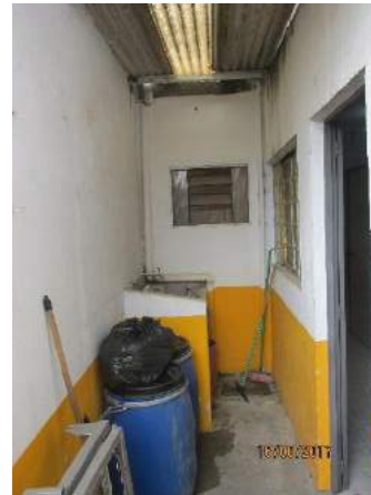
FIGURA 78 - ARMAZENAMENTO IRREGULAR DE RSS NO ESF-B (FONTE: ACERVO DO AUTOR, 2017)
